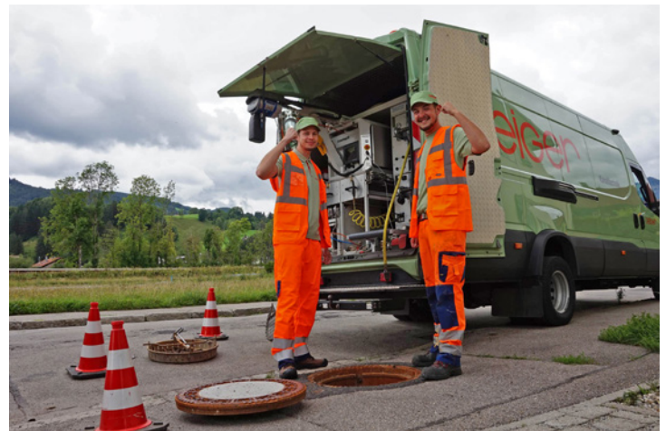
Auszubildende auf der Baustelle mit einem Inspektionsfahrzeug.
